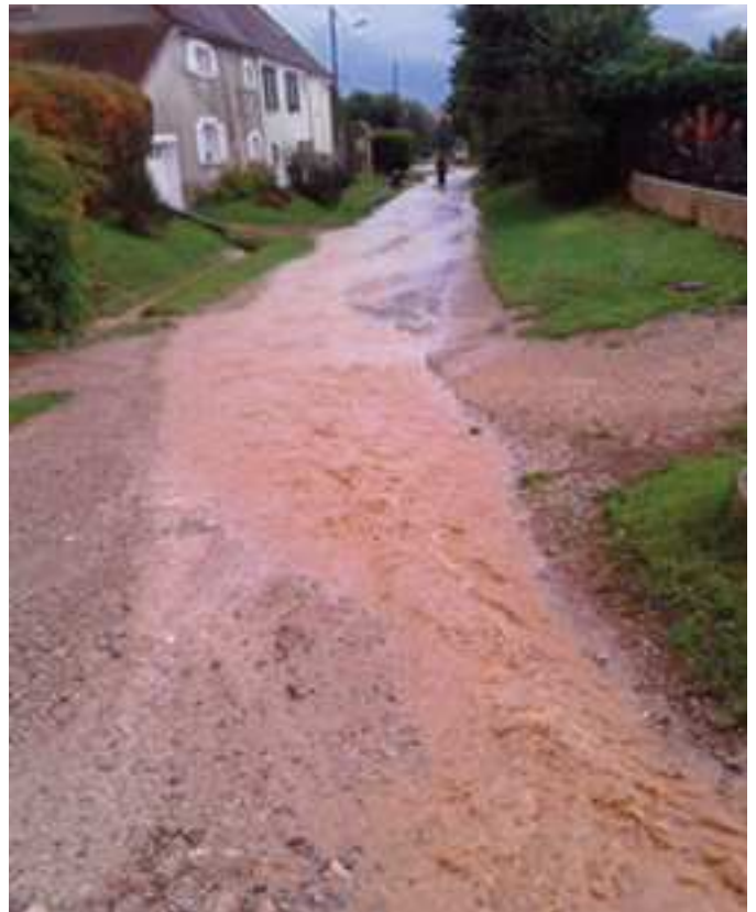
Avant les travaux : torrent s'écoulant des champs vers la rue du Tilleul
